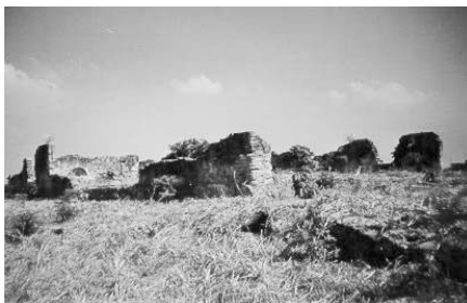
Ruínas da edificação presente no alto da Ilha
